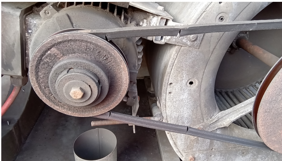
Courroie endommagée
