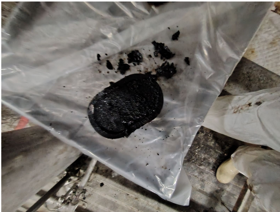
Trappe de visite HS - remplacée
